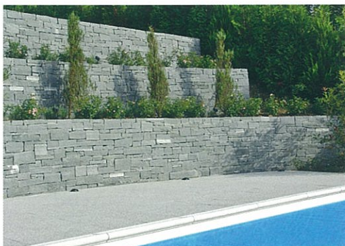
Tessiner-Gneismauer, Schottischer Mauerwerksverband
