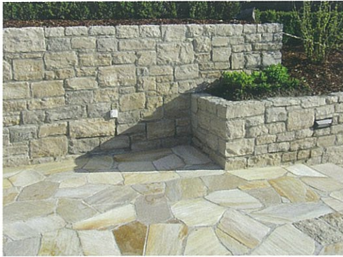
Jurakalk-Kleinmauersteine in diversen Lagen.
