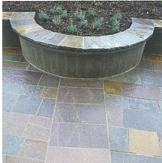
Abdeckplatten konvex/konkav (Aussen- und Innenradius).
