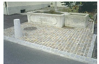
Porphyrreihenpflasterung mit Graniteinfassung (gebundene Bauweise)
