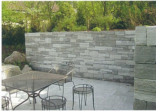
Gneis-Schichtenmauerwerk mit Pressfugen ohne Mörtel
