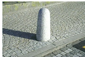
Granitpoller auf Granitbogenpflasterung (gebundene Bauweise)
