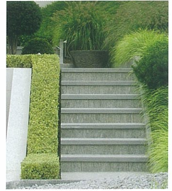
Tritt- und Stirnplatten geflammt. Sichtkanten geflammt mit Fasen.
