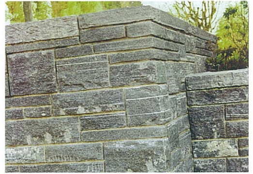
Gneis-Mauerwerk schottisch mit Holfugen
