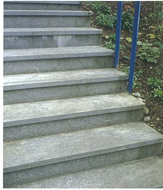
Tritt- und Stirnplatten geschliffen. Sichtkanten gefräst.
