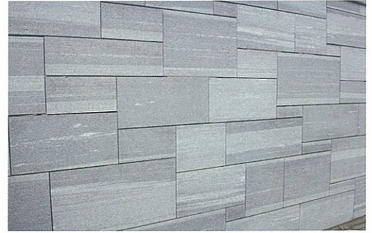
Wandverkleidung mit Tessiner-Gneis, gesägt in verschiedenen Abmessungen
