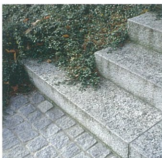
Blockstufen in massiver Ausführung. Oberfläche geflammt. Sichtkanten gestockt oder sandgestrahlt.
