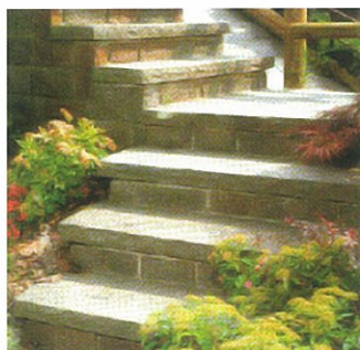
Tritt- und Stirnplatten aus Porphyr, naturgespalten und handbekantet.
