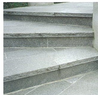
Trittplatten gewandelt. Oberfläche naturgespalten und Sichtkanten bossiert.
