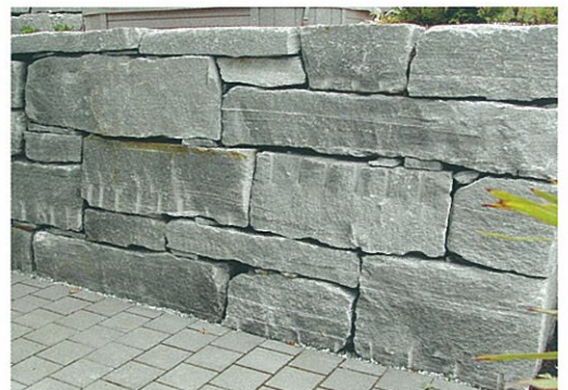
Tessiner-Gneis-Quader in div. Stärken, trocken geschichtet
