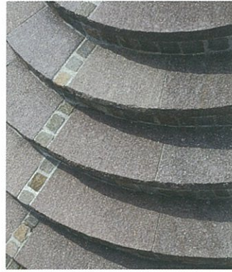
Trittplatten konvex (ausen) naturgespalten mit bruchrohen und nachbearbeiteten Sichtkanten.
